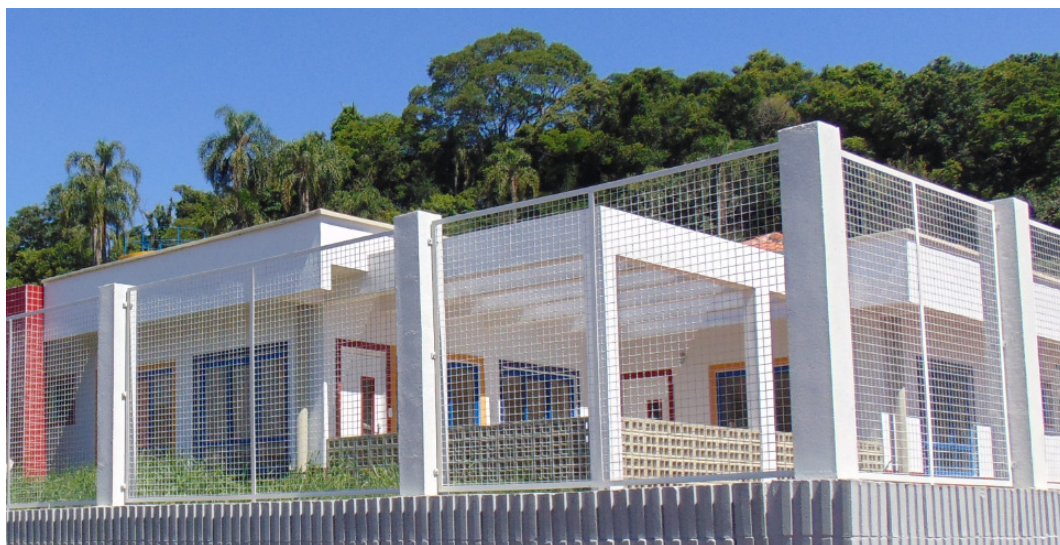
Exemplo de cercamento com gradil metálico.
