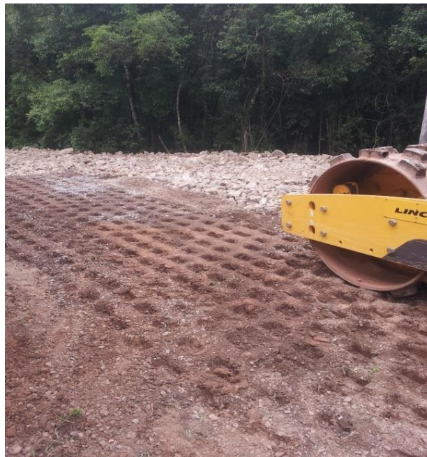
Foto 3 – compactação mecânica do subleito e base.
