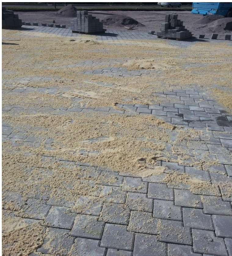
Foto 6 – areia fina deve ser varrida para rejuntamento e preenchimento das juntas.
