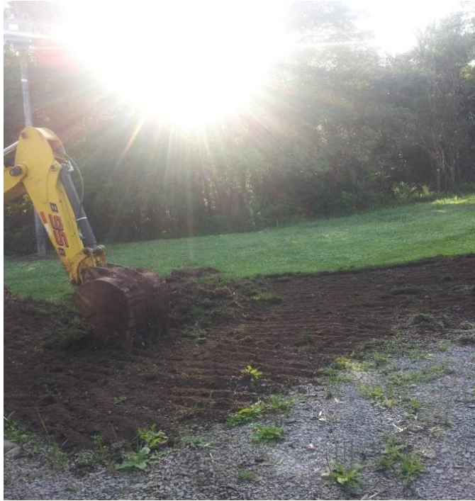
Foto 2 – limpeza e regularização do terreno.
