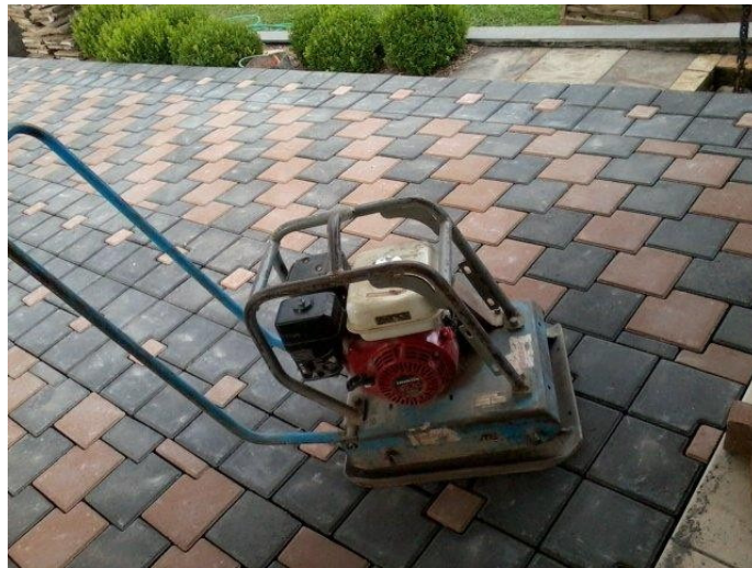
Foto 5 – placa vibratória utilizada para compactação do pavimento após assentado.
