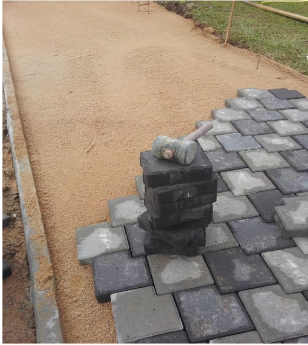
Foto 4 – camada de areia (espessura 7 cm) para assentamento do piso.
