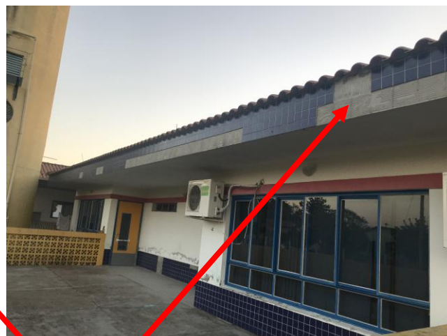
Exemplo de DESCOLAMENTO DO REVESTIMENTO CERÂMICO DA FACHADA
