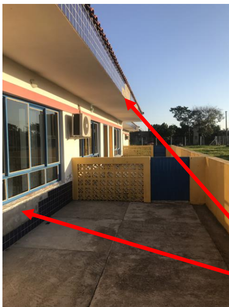
Exemplo de DESCOLAMENTO DO REVESTIMENTO CERÂMICO DA FACHADA
