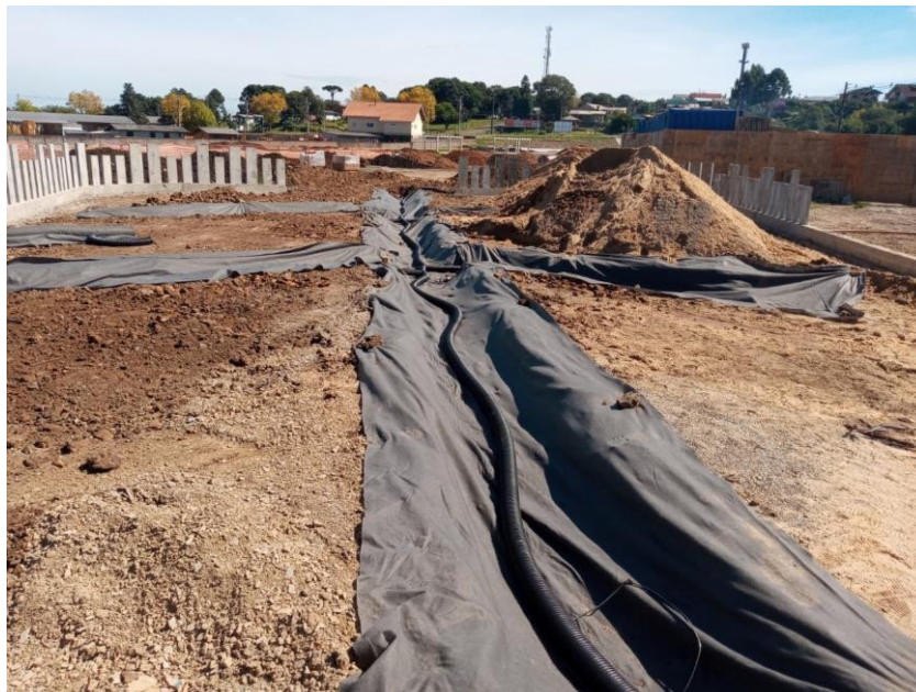
Exemplo do sistema de drenagem
